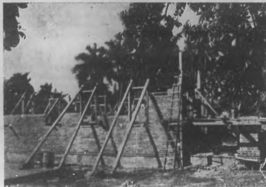
Aspecto de una casa de ladrillo, en construcción, en el Reparto.
