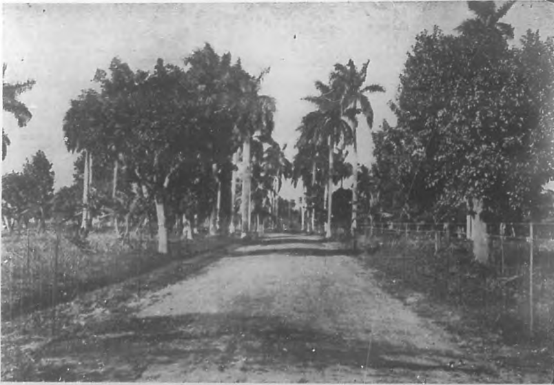
Una vista de la calzada de tarvia que atraviesa el Reparto.
